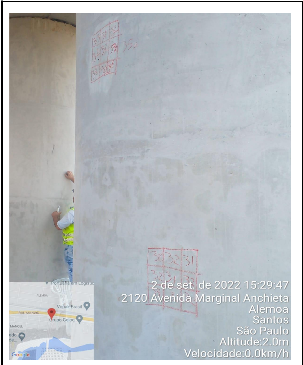
Foto 03: Marcação de pontos para realização do ensaio de esclerometria.
