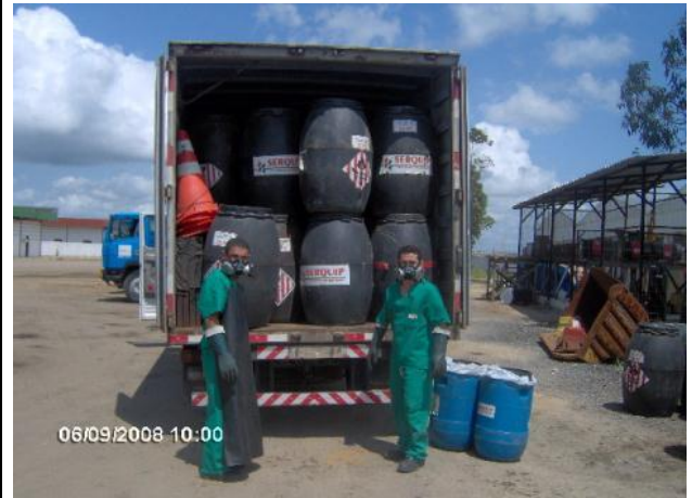
Destinação adequada de resíduos sólidos contaminados no canteiro de obra.
