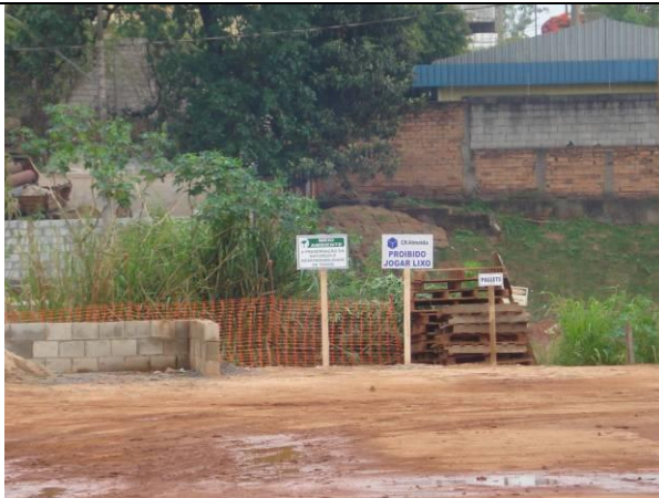
Sinalização educativa realizada em canteiro de obras.
