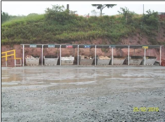
Área para armazenamento de resíduos não contaminados em caçambas estacionárias.
