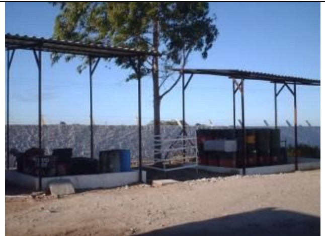
Área para armazenamento de resíduos contaminados.
