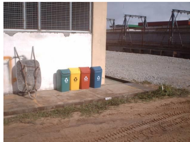
Coletores seletivos em pátio do canteiro de obras.
