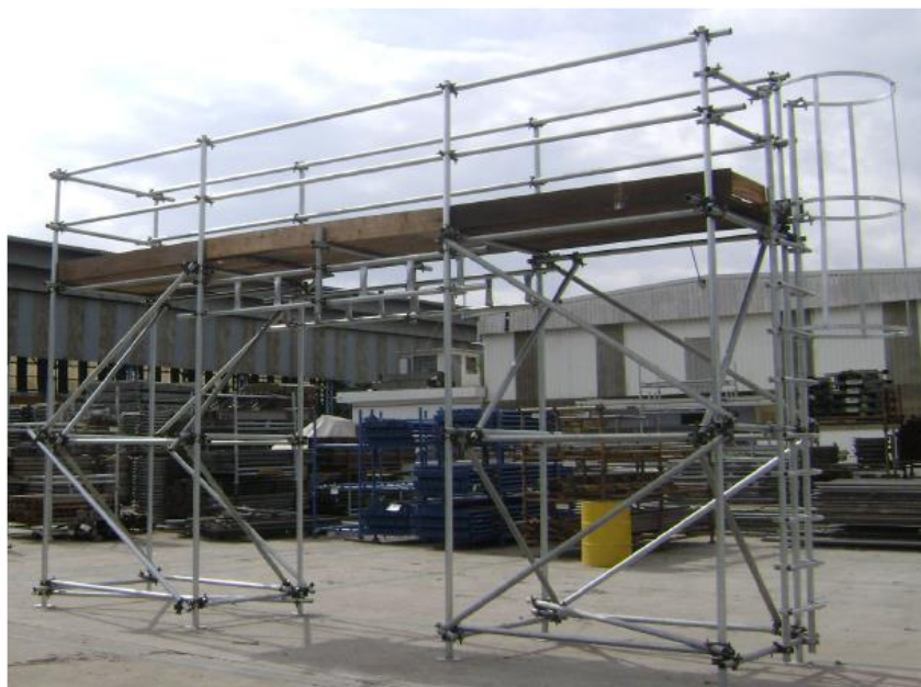
FIGURA 3 – andaime tubular convencional tipo Passarela
